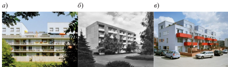
Рис. 3. Пример сноса верхних этажей и трансформации блоков: а), б) – проект Stefan Forster Architekten в Гале; в) – проект в Лайнефельде. Фото: Stefan Forster Architekten
