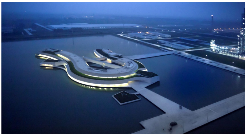
Рис. 2. Производственное здание в Хуайань в Китае
