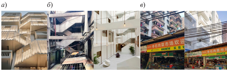
Рис. 8. Реконструкция панельного дома в Гуанчжоу по проекту бюро TEAM_BLDG : а), в) – экстерьеры; б) – интерьеры.
