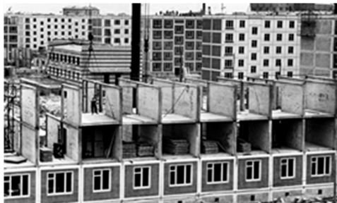
Рис. 1. Строительство панельного дома. Источник: livejournal.com
