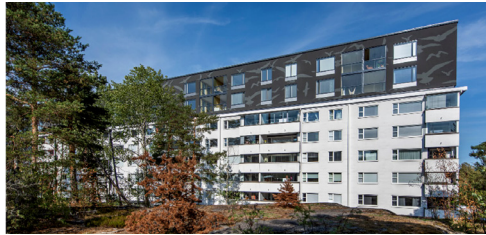
Рис. 5. Пример надстройки этажей в Хельсинки. Источник: lehto.fi/en/referenssit/alakiventie-helsinki/
