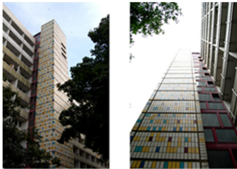
Рис. 12. Пристройка лестнично-лифтового узла
